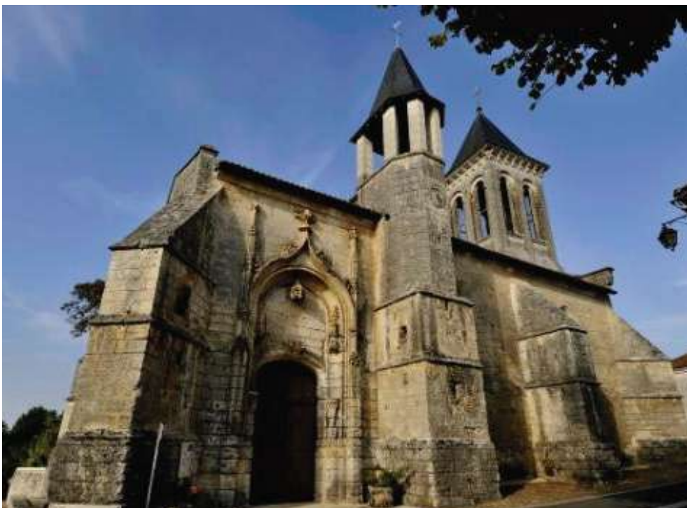
Façade sud de l'église
