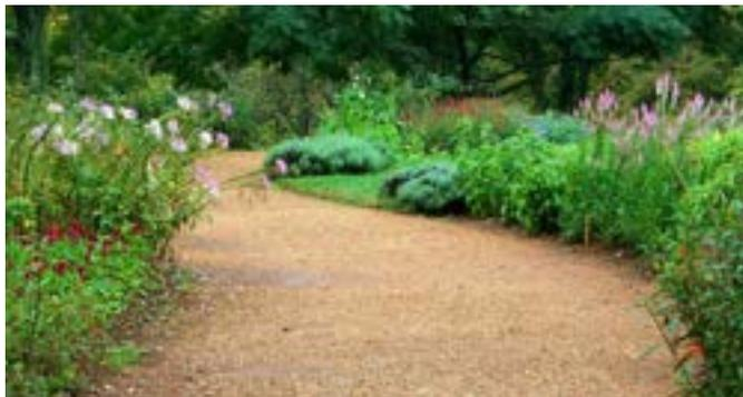
Cheminement piéton en gravier stabilisé, perméable.
