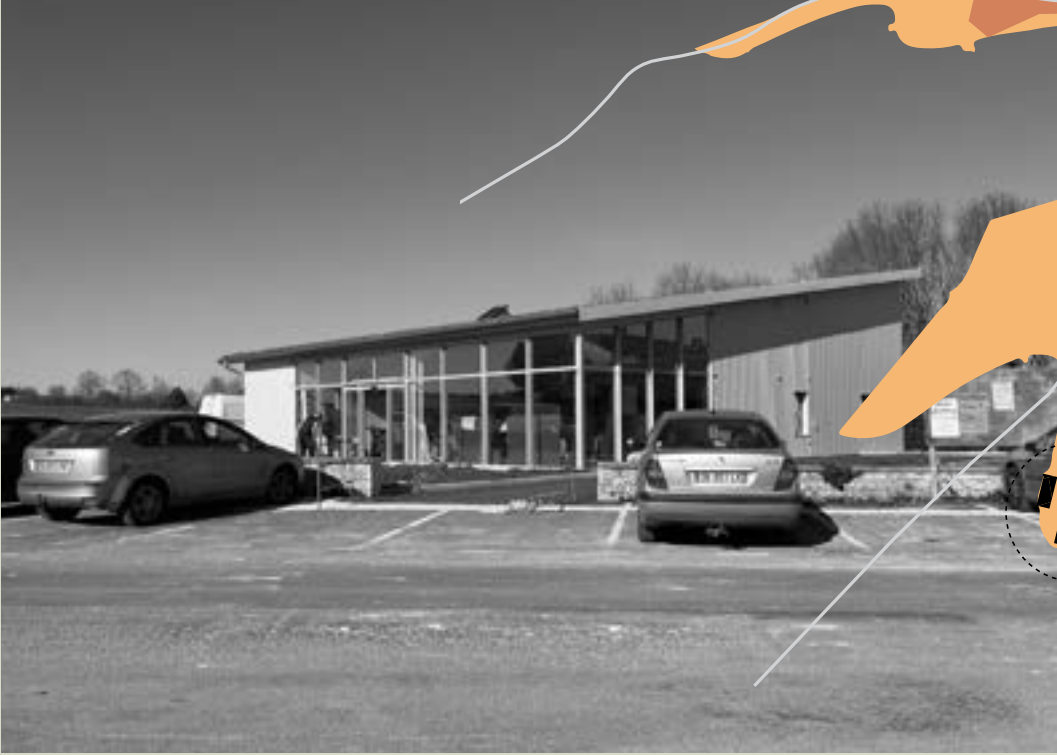
Construction d'un nouvel équipement de santé sur d'anciens terrains agricoles.
